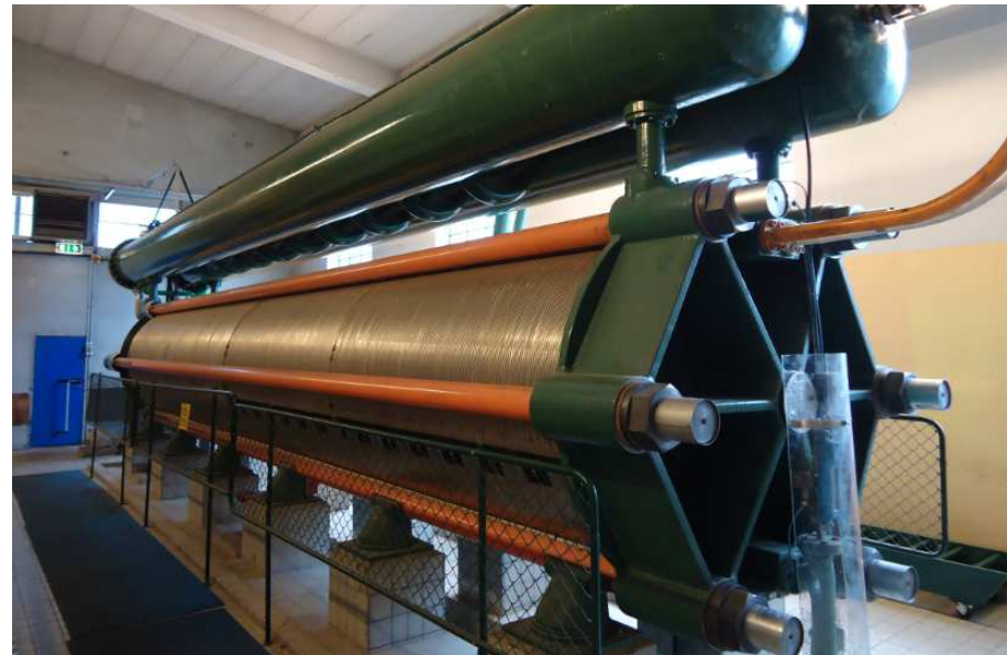
IHT electrolyser – 3.5MW – 760Nm 3 /h H 2
